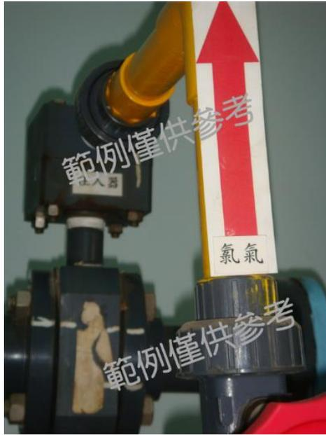
圖 3-3、氯之運作導管、配管流向標示
